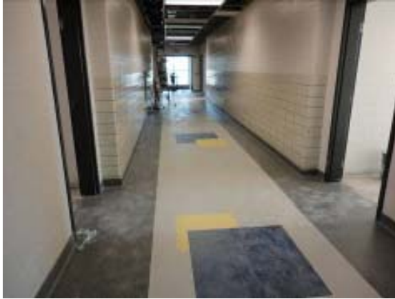
Terrazzo in Corridor
