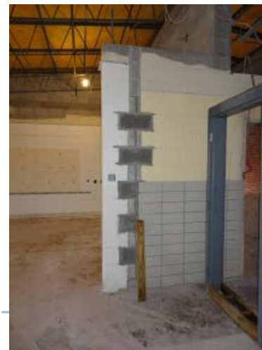
Door Frames / Existing Walls
