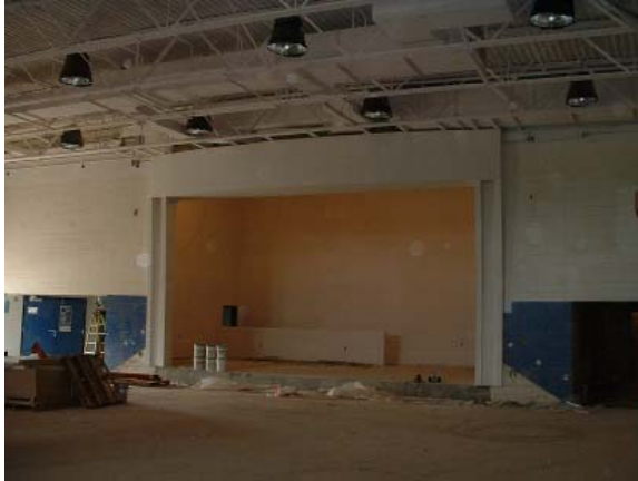
Primer & First Coat Paint
