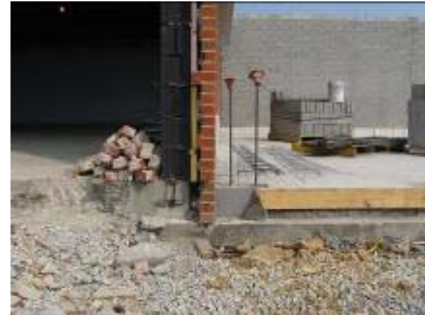
New Admin. Suite Slab
